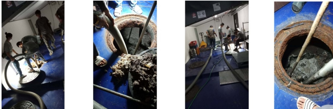
ภาพที่ 4-7 การสูบน้ำมัน และบ่อพักตะกอนออกทุก 3 เดือน
